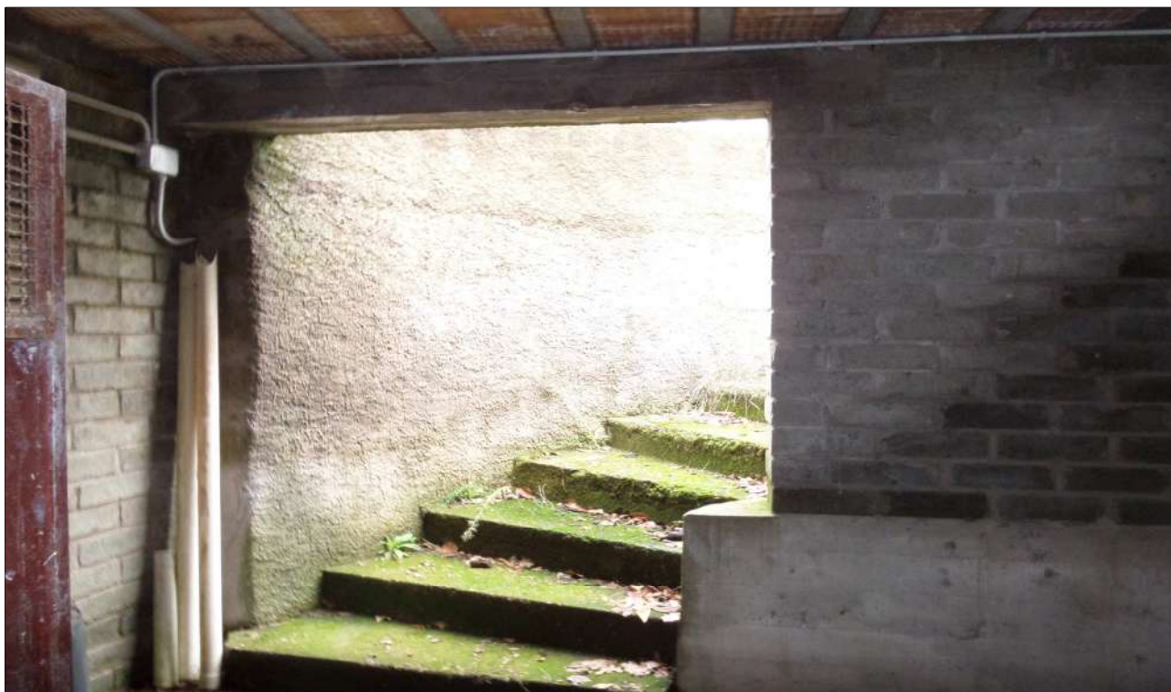
Figura 43: Ingresso alla cantina
