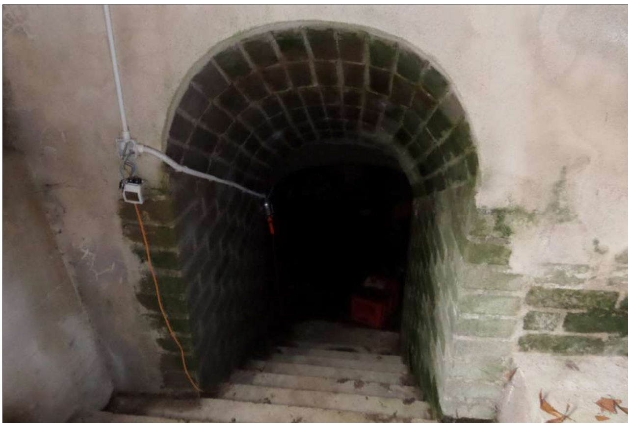
Figura 45: Gradini per l'accesso al livello 2 della cantina scavata nel tufo
