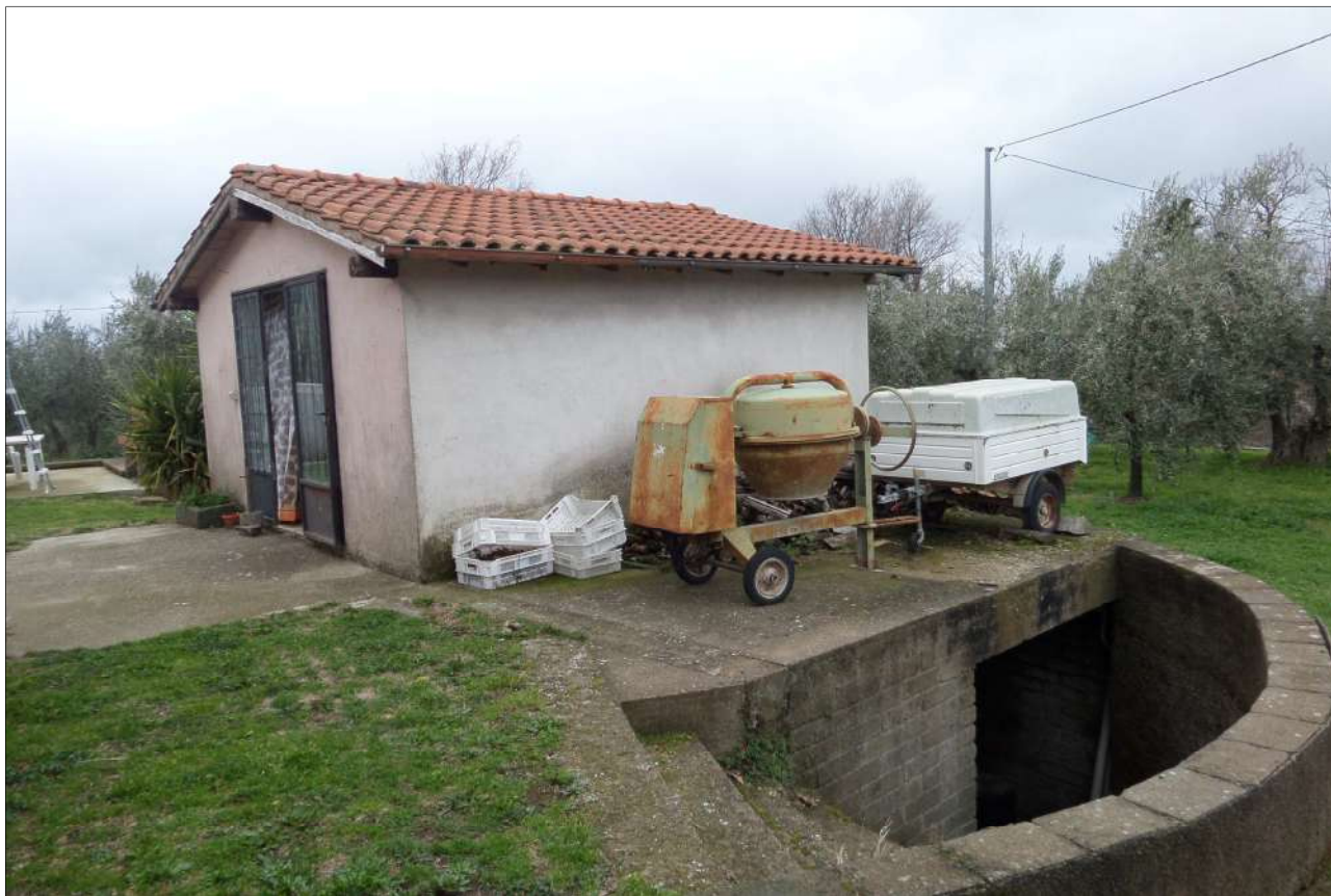
Figura 39: Vista esterna fabbricato rurale 1 con accesso sottostante cantina
