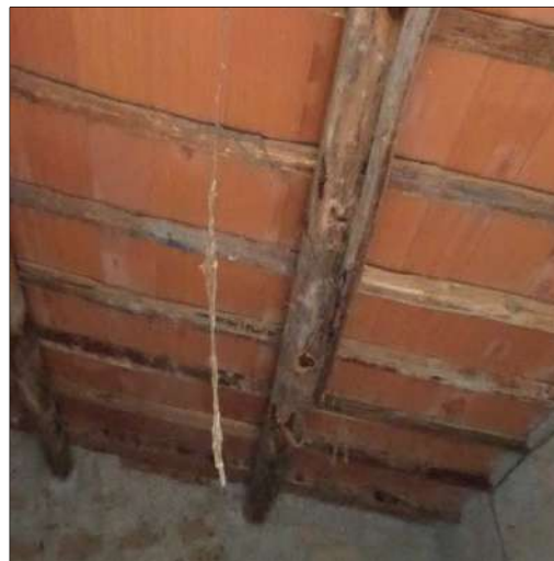
Figura 16: Particolare solaio magazzino
