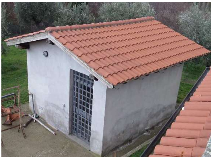
Figura 42: Vista dall'alto fabbricato rurale 2
