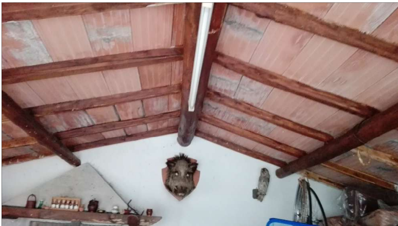
Figura 36: Solaio fabbricato rurale 1
