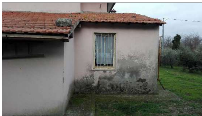
Figura 3: Vista esterna lato Sud-Est
