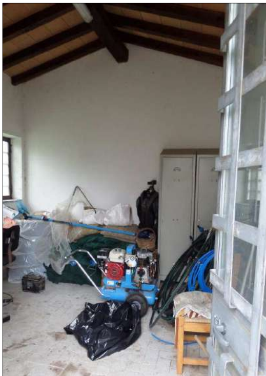
Figura 41: Vista interna fabbricato rurale 2
