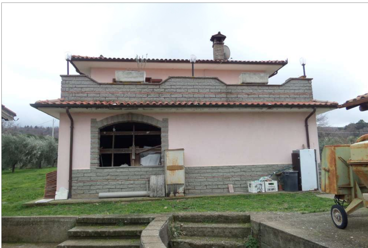
Figura 5: Vista esterna lato Nord-Ovest
