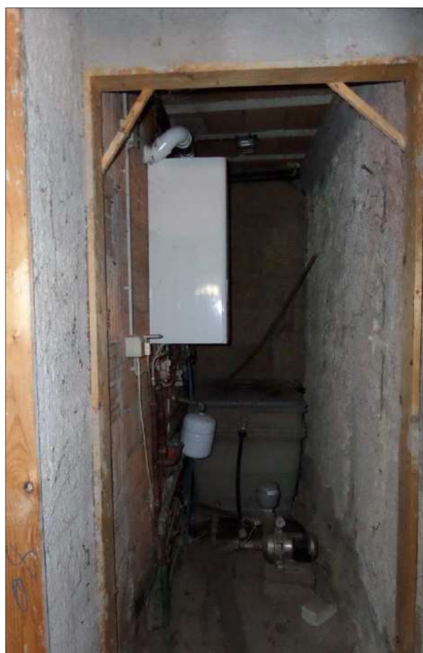
Figura 19: Ripostiglio piano terra
