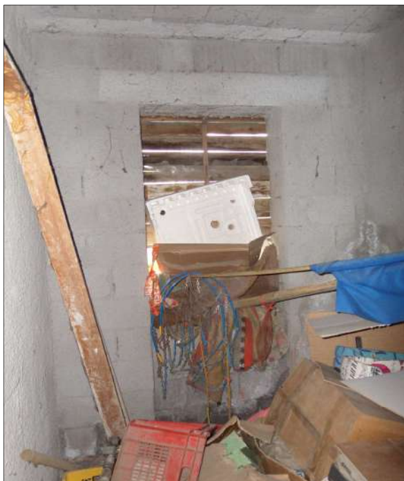
Figura 20: Ripostiglio piano terra
