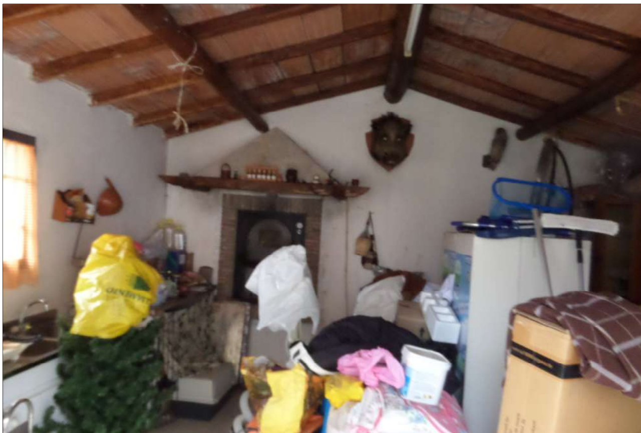
Figura 37: Vista interna fabbricato rurale 1
