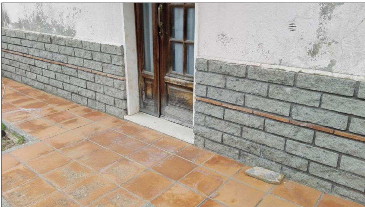
Figura 33: Terrazza piano primo
