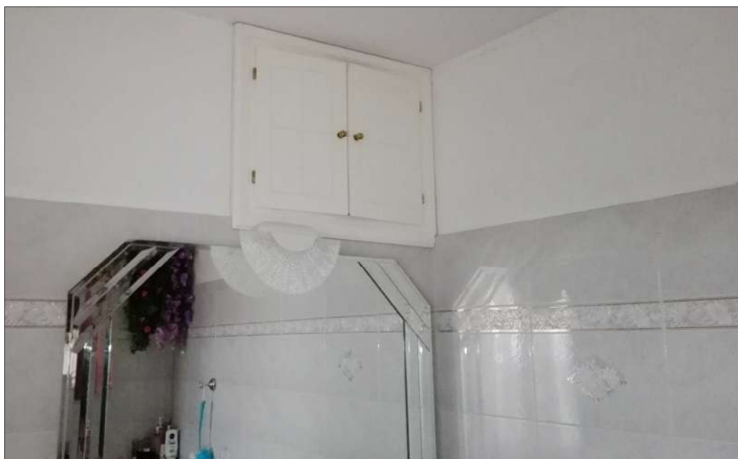
Figura 32: Particolare nicchia nel bagno
